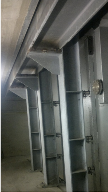
Ofenaußenansicht, Stahlbau (Traggerüst)
